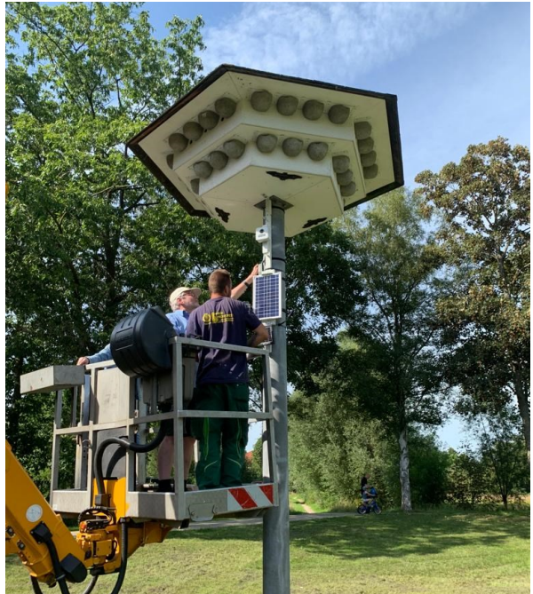
Installation Lockrufanlage Schwalbenhotel Foto: © Dietmar Sieg
