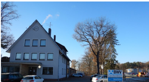
Abbildung 1: Verwaltungsgebäude des Betonwaren-Werkes. Unter den locker auf dem Ortgang des Giebels liegenden Dachziegeln brüten mindestens 25 Mauersegler-Paare in einer größeren Kolonie. In die Eichenreihen zwischen Gebäude und Straße (ganz rechts im Bild) wurden 2016 und 2017 neun Nistkästen in Dreiergruppen gehängt.
